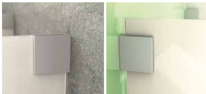
Wandbefestigung (links Befestigung der Seitenwand, rechts Befestigung der Urinaltrennwand)
