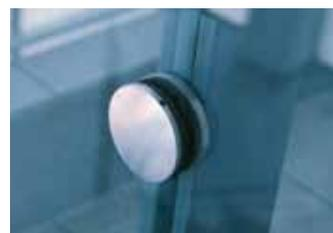
Bild 1: Punktförmig geklemmte Verglasung mit sehr hohem Sicherheitsanspruch.
