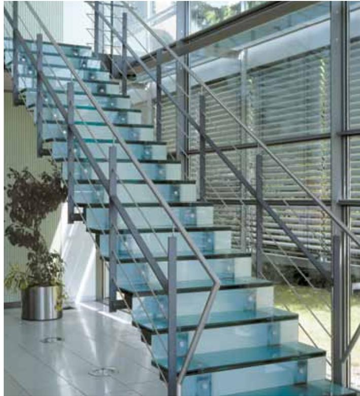
Begehbares Verglasungssystem mit Setzstufen in VSG und hellmatter Folie. Innovative Befestigung mit Senkschrauben SPRI-POINT 32/10. Rutschhemmender keramischer Siebdruck mit Punktedekor für Trittsicherheit.
