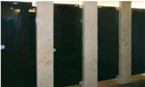
BASF, Ludwigshafen: TWS 200 in ESG 10 mm mit keramischem Siebdruck ganzflächig schwarz (RAL 9011). Sonderbeschläge für Befestigung an Steinsäulen.
