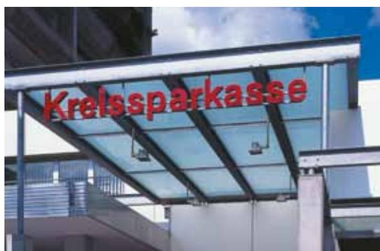
Linienförmig gelagertes Vordach.
