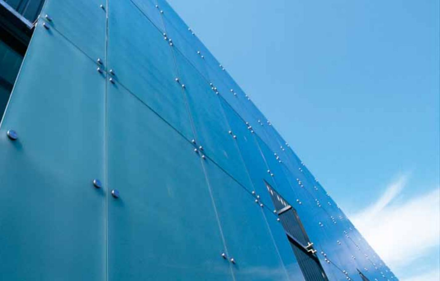
Diese punktgehaltene Fassade ist sowohl Gestaltungselement als auch Teil des Schallschutzkonzeptes. Die einzelnen Glasplatten aus 12 mm starken VSG-Platten (2 x ESG mit PVB-Folie) erhalten ihre milchige Optik durch die hellmatte Folie. Jede der VSG-Platten ist mit den Punkthaltern SPRI-POINT 50 befestigt und sitzt vor einer Blechverkleidung.
