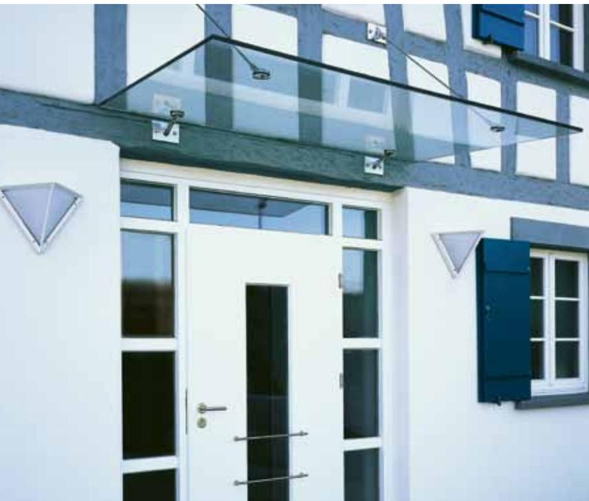
Punktgehaltenes Vordach, 2100 x 1250 mm, aus Klarglas. Die leichte, filigrane Optik tritt dezent hinter den historischen Fachwerkbau zurück. Verwendet wurde der Punkthalter SPRI-POINT 70. Punkthalter, Konsolen und Zugstäbe aus Edelstahl.
