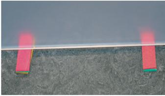
10. Stellen Sie die ESG-Glastafel auf die Unterlegplatten und schieben Sie den Beschlag zur Glasöffnung.
